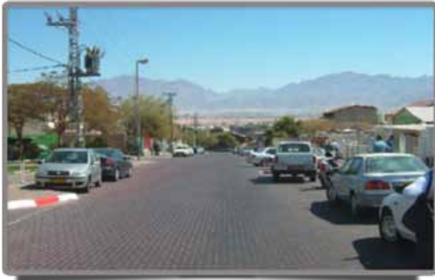
Figura 1.3 Pavimento vehicular de adoquín de hormigón después de 10 años de construcción. (Eilat, Israel).
