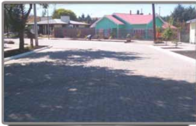
Figura 1.4 Pavimento de adoquín de hormigón en calles de bajo tránsito en Trevelin, Argentina.
