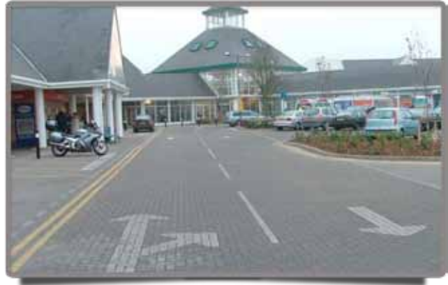
Figura 1.11 Pavimentos de adoquines en calles interiores de centros comerciales.
