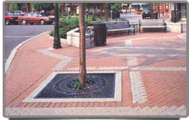
Figura 1.12 Espacios peatonales con pavimentos de adoquines.
